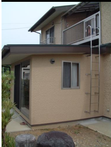
避難誘導用タラップ部
