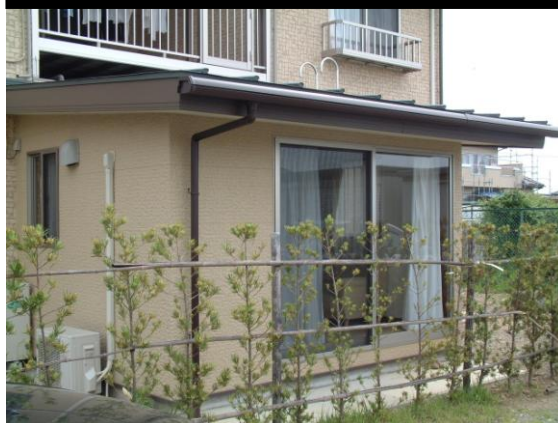
工事箇所全景
